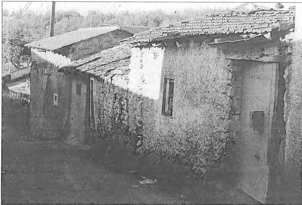
Uma casa antiga, em ruínas.
